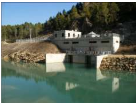
Minicentral hidráulica en Fuensanta (Albacete)
